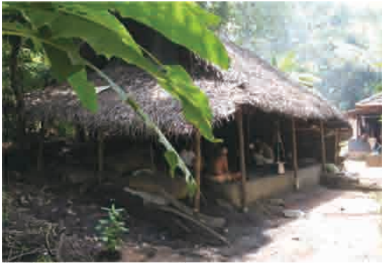
巻頭写真 1 APPUNI 工房 工房は一段高い土間で、3面の壁がなく通風が良い。
